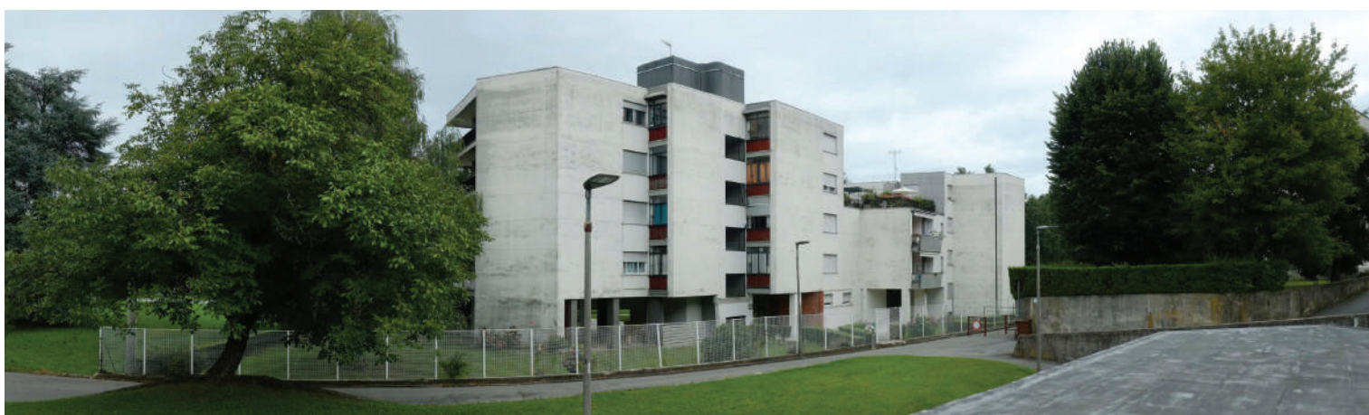
Fig. n. 2.a.2.14: Edificio 18 alloggi, fronte nord
