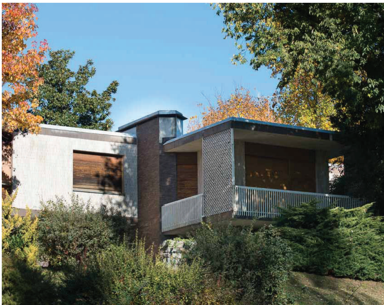
Fig. n. 2.a.2.11: Villa Rossi, fronte sud
