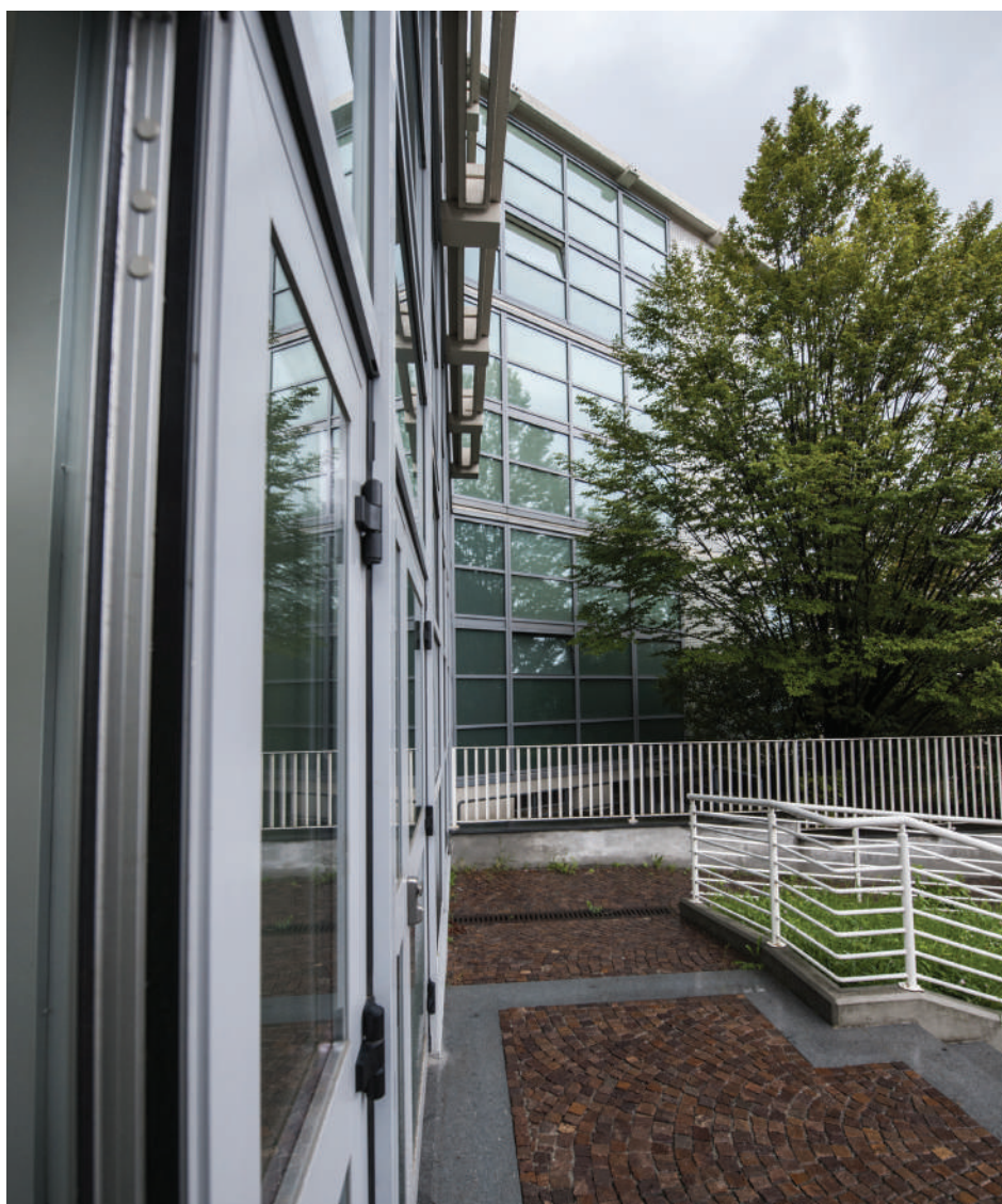
Fig. n. 2.a.2.41: Officine ICO, quarto ampliamento, particolare del fronte sud
