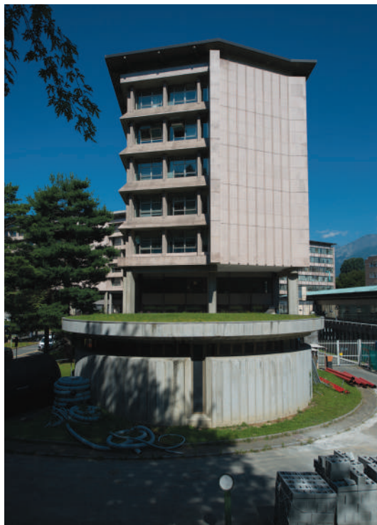
Fig. n. 2.a.2.2: Palazzo Uffici Olivetti, fronte sud-ovest, particolare
