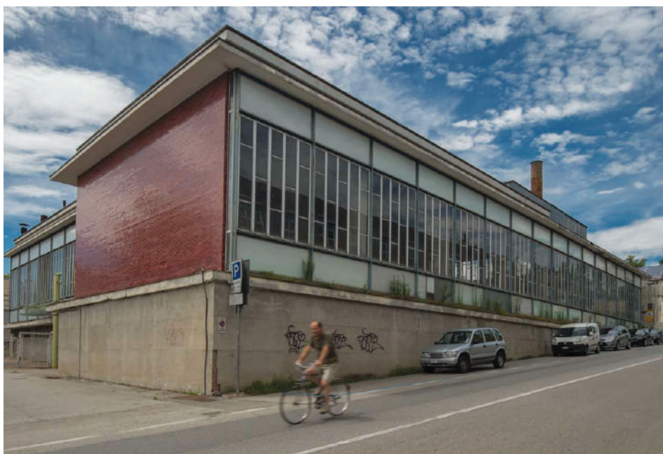
Fig. n. 2.a.2.69: Centrale termica, via Di Vittorio, fronte ovest
