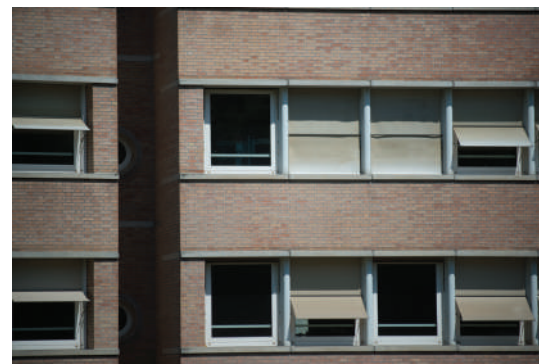
Fig. n. 2.a.2.8: Nuovo Palazzo Uffici Olivetti, fronte nord, particolare
