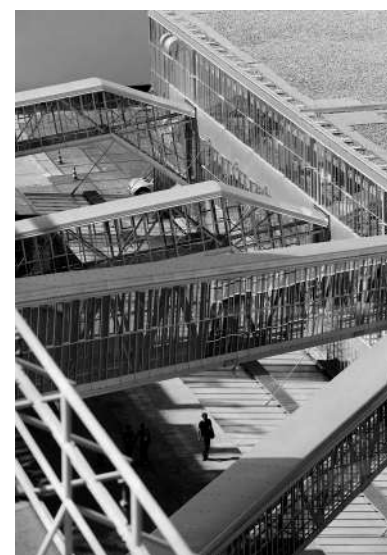
Fig. n. 3.2.55: Van Nelle fabriek, Foto aerea del complesso, 2010
