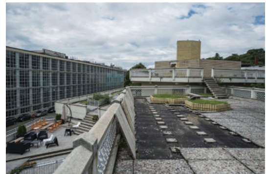
Fig. n. 2.a.2.57: Centro dei Servizi Sociali, ala est, secondo livello, particolare dei solarium
