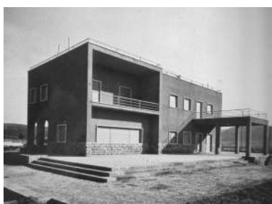
Fig. n. 3.2.59: Sulcis Iglesiente, Panorama del villaggio operaio di Bacu Albis, 1939-1940
