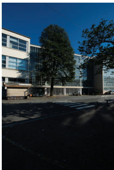
Fig. n. 2.a.2.35: Edificio "Mattoni Rossi", fronte nord
